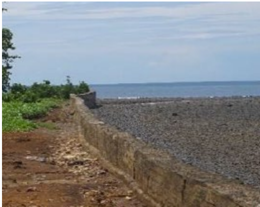
A. digue en béton
